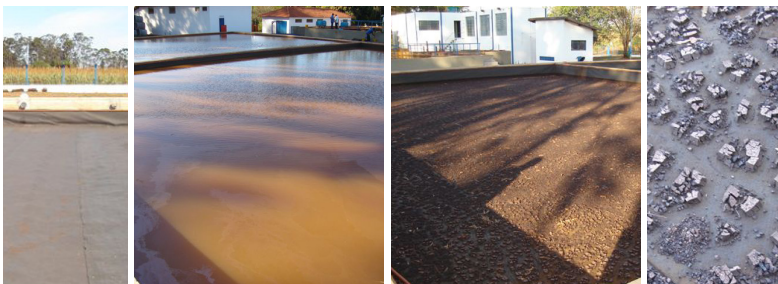
Figura 7: LD da ETA de Guaira/SP: manta geotêxtil, LDs cheios e LDs com lodo desaguado.
