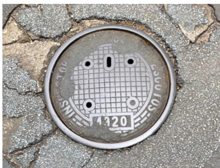
Figura 3: Tampão com a inscrição Inspetoria Municipal de Águas e Esgotos - 1920 .
