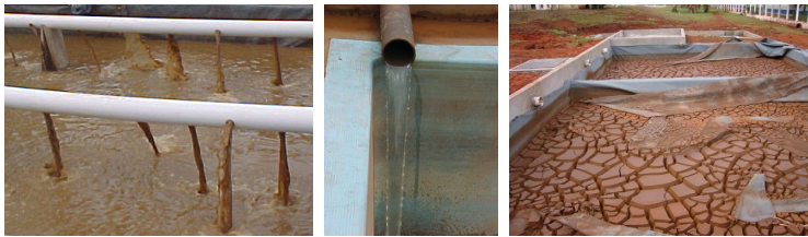
Figura 5: LD construído na ETA de Cardoso/SP (sequência ilustrando o despejo do lodo no leito, a água livre drenada no momento inicial e o lodo “seco” no fim das operações).
