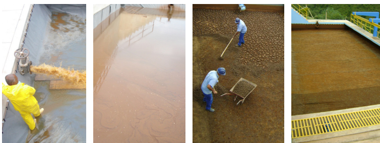
Figura 9: ETA de Guanhões/MG: despejo de lodo em LD, leito com lodo bruto, remoção de lodo desaguado e LD pronto para receber novo despejo.
