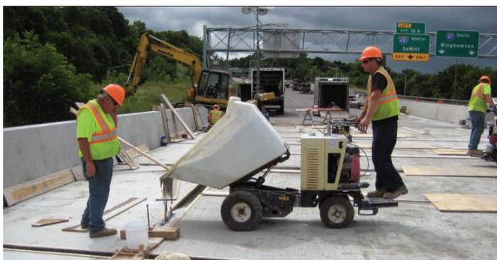
**Figura 9** – Despejo do UHPC para nas conexões pré-moldadas – FHWA-HRT-19-011.
