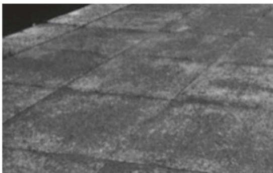
**Figura 4-** Placas de concreto permeável
