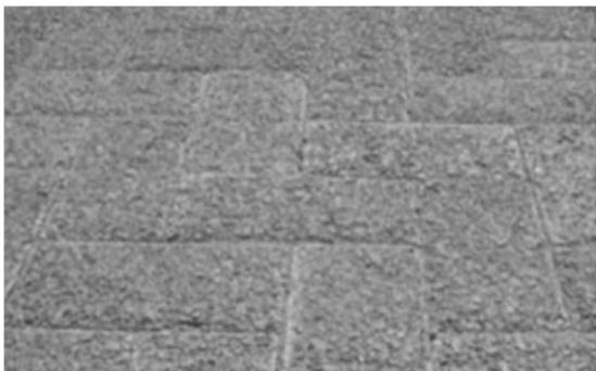
**Figura 3-** Peças de concreto permeável
