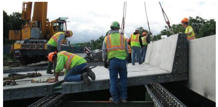
**Figura 5** – Posicionamento dos painéis pré-moldados com os guarda-corpo integrados. – FHWA-HRT-19-011.
