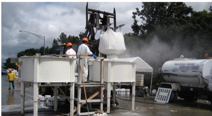
**Figura 8** – Misturadores produzindo o UHPC – FHWA-HRT-19-011.
