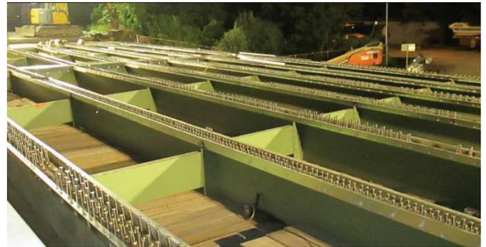
**Figura 4** – Superestrutura preparada para a instalação dos painéis pré-moldados. – FHWA-HRT-19-011.
