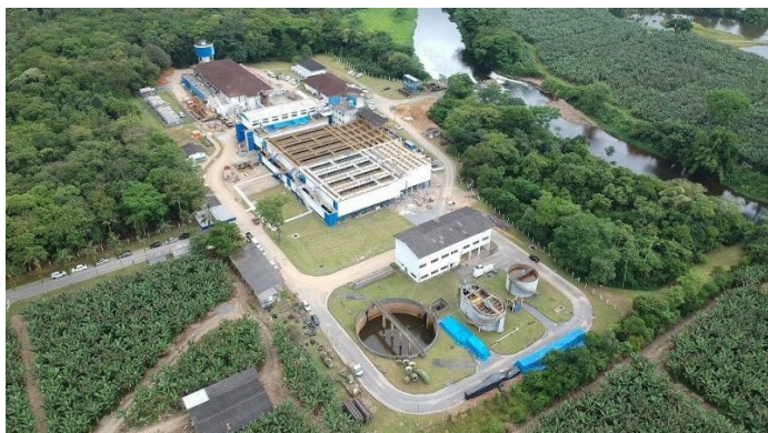
Figura 1 – Estação de tratamento de água do Rio Cubatão- Joinville.
