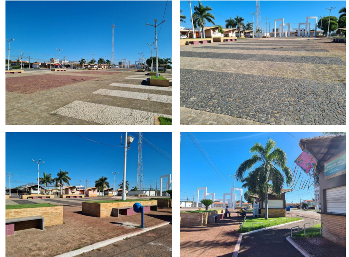
Figura 04: Superfícies da praça: áreas com piso intertravado cinza, pedras portuguesas (vermelho, preto e branco), grama, pedras naturais e asfalto.
