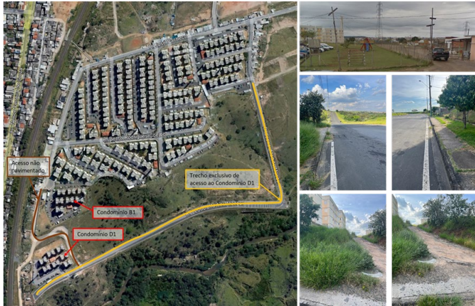
Figura 7- Acesso ao Condomínio D1. Fonte: Imagem aérea adaptada de Google Earth. Fotografias capturadas no local entre os dias 27 fev. e 03 mar. 2023.
