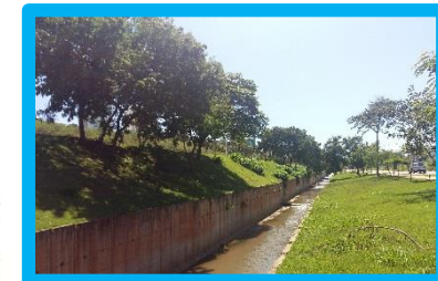
Canalização do Córrego do Gregório
